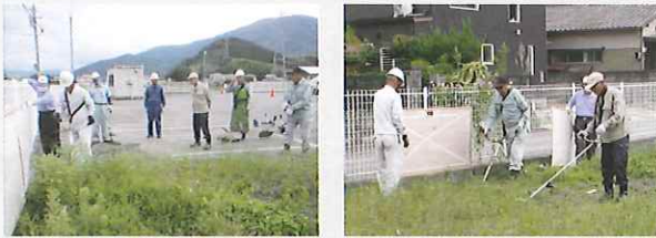
飛散防止ボードを使っでの草刈り作業
